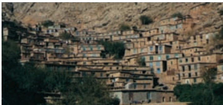
شکل ۴۰-۲- روستای پلکانی هجیج در منطقه‌ی پاوه‌ی کرمانشاه
