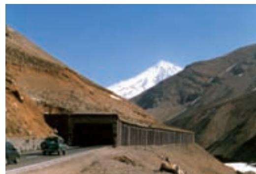
شکل ۶-۲۷—دو نوع بهمن‌گیر در جاده هراز، راهی برای مقابله با خطر بهمن
